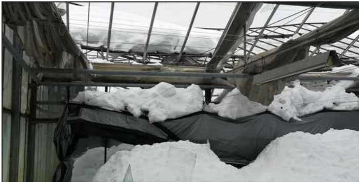
Photo 1 : certaines exploitations en Bavière ont sévèrement souffert sous des épaisseurs de neige atteignant parfois 2m.
