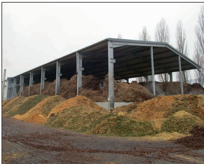
Photo 1 : Entrepôt à copeaux de bois en plein air et sous toit
